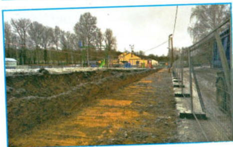
■ Přípravné práce pro výstavbu nového oplocení
