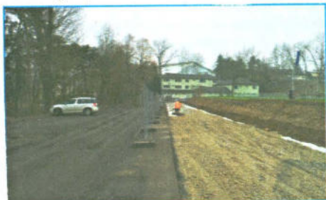
■ Příprava pláň pro pokládku konstrukčního souvrství a pokládka silničních obrubníků
