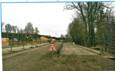
■ Pokládka konstrukčního souvrství na odstavných plochách
