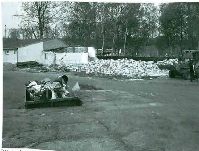
Přístavba šaten na letním stadionu začala demolici starého objektu
