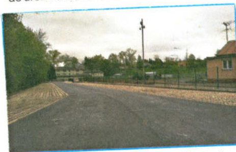
■ Nový asfaltový povrch u areálu Letního stadionu
