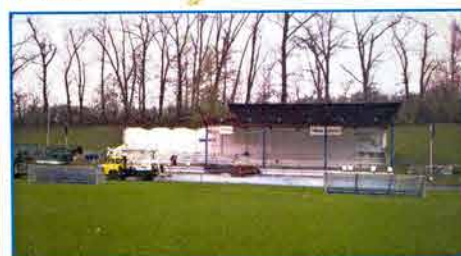
Probíhající rekonstrukce tribuny na fotbalovém stadionu
