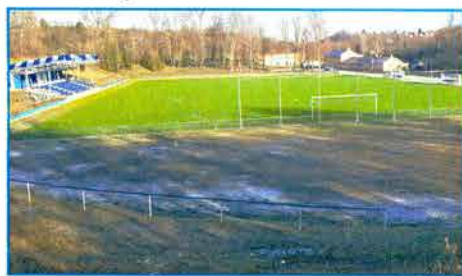
Rekonstrukce fotbalového hřiště byla dokončena
