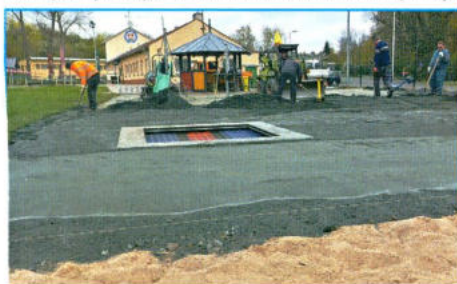
■ Štěrkový podklad pro nový povrch
