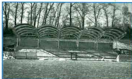
■ Rekonstrukce tribuny – v únoru bylo dokončeno zastřešení
